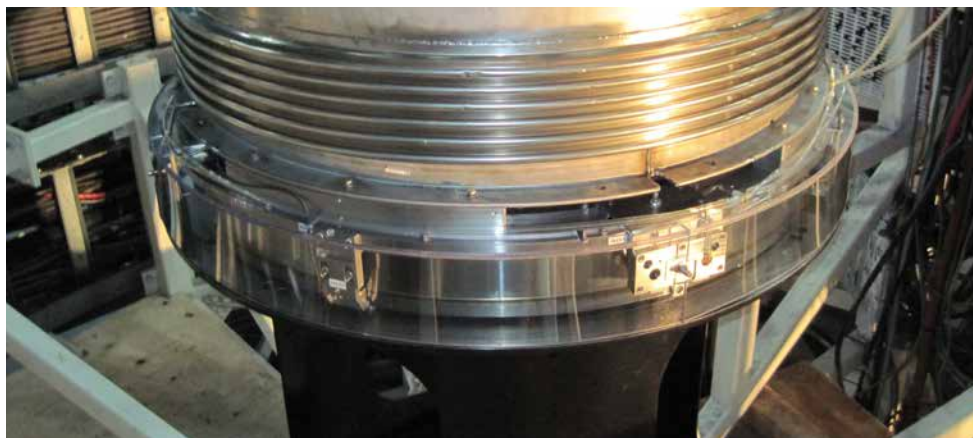
Montaggio dei sistemi di misura angolari ERA 8400 sull'azionamento del telescopio per il posizionamento azimuth
